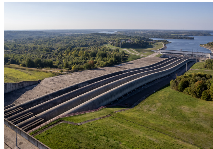
Kruonio hidroakumuliacinė elektrinė, Lietuva
